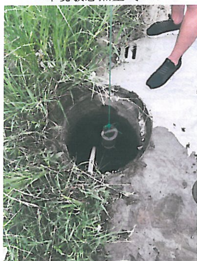
生活污水总排口★1
